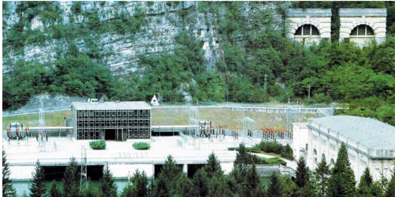
La centrale Enel ad accumulazione mediante pompaggio di Fadalto che utilizza le acque del sistema Piave-Santa Croce e che ha una potenza di circa un quinto rispetto a quella progettata a Camp Martin sul lago di Poschiavo (Svizzera).
